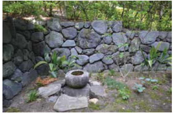
写真 13 書院裏のつくばいと土留めの石垣
