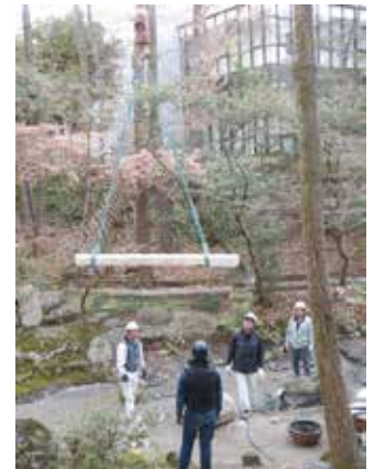
写真 18 木橋から石橋へ改修
