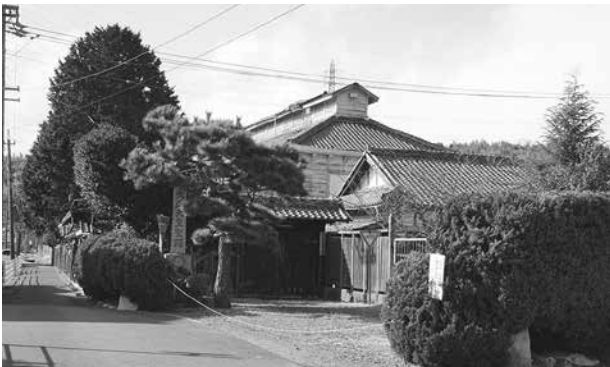
写真7 亀山製絲(株)室町工場 正面をみる
