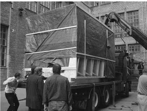
fig.12: 完成したサウナがクレーンによってトラックに積載される様子
