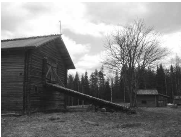
fig.13: 木造住宅群の中核をなす厩つきの住戸。1階は厩になっており、2階に飼料を備蓄する。干し草を積んだ馬車のための斜路が見える。
