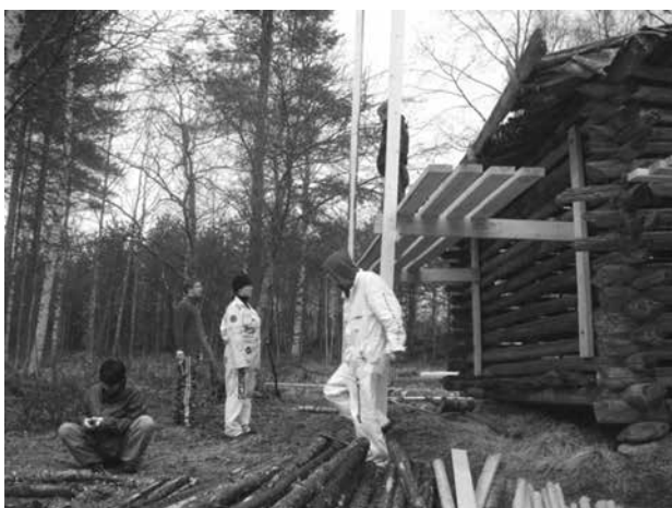
fig.14: 修復対象の建物周囲に足場を架ける。
