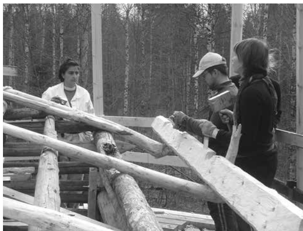
fig.16: 根曲がり材による軒桁。端部に板材を引っかけ、鼻隠し状の雨樋とする。
