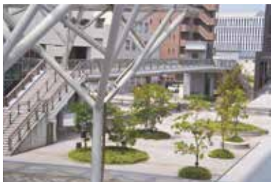
写真 5 太田川駅西歩道 (30m 歩道)
