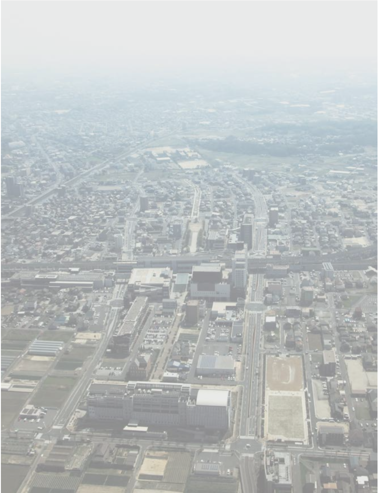
写真1 東西に1kmの緑地が名鉄太田川駅を貫いて通る。
