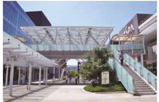
写真 20 駅西口を出ると30m歩道に大屋根が広がる。
