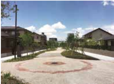
写真 2 太田川駅東歩道 (15m 歩道)
