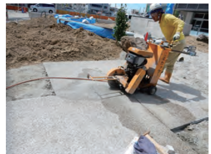
写真29 コンクリート舗装にカッター目地を入れる。
