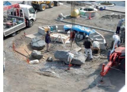
写真26 歩道で最も大きい景石を据える。
