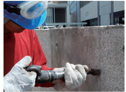
写真23 「対面の像」の台座のコンクリートをはつる。
