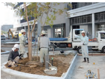
写真30 樹木を植える。地下支柱を設置。
