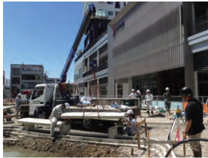
写真22 彫刻ベンチを現場に設置。
