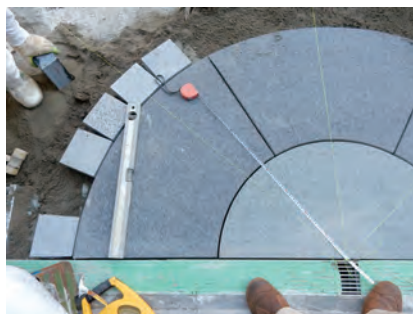
写真28 円形舗装の中心の石張り。
