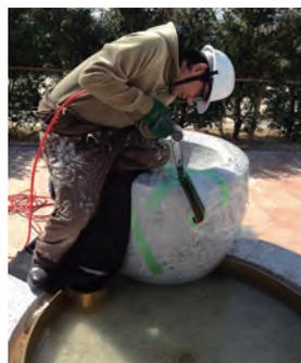
写真26 真鍮の水口を現場で調整。
