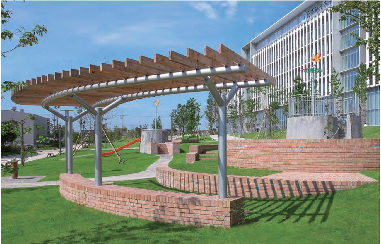
写真9 子供広場の太陽の砦から月の砦を臨む。円形のレンガ小壁が重なり合いリズムを作る。アクセントに水色のタイル(太田川駅東側の「どんでん広場」で使用した色)を埋め込んだ。パーゴラ下はベンチとなっている。壁の高さは安全に配慮し90cm未満に抑えている。
