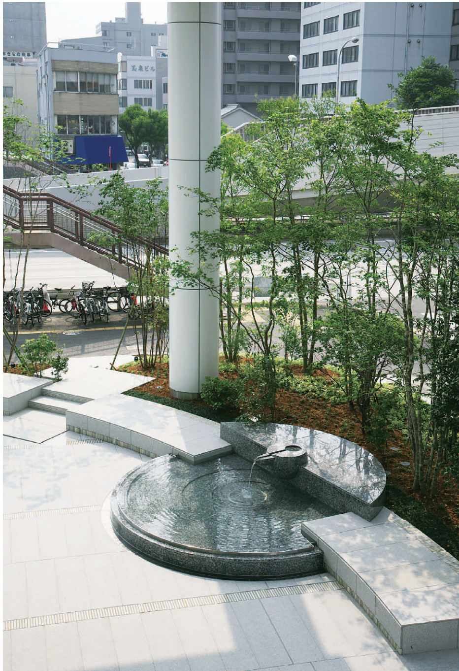
水景と舗装。エントランスは円形に区切られた植栽で包み込むようなデザインとした。舗装は白ミカゲ石にスクラッチ仕上げをし、焼物のタイルでラインを入れリズムをつけた。(アルペン丸の内タワー、2007/6)
