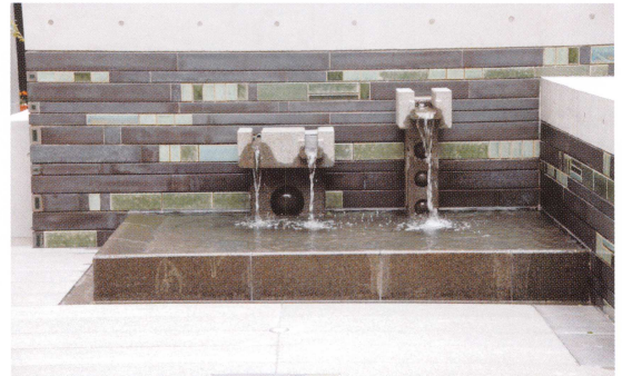
吐水口。音による和みの空間。後ろの壁にはルーバー用の大型タイルを詰め織部釉などの陶板を配した。(2005年5月)
