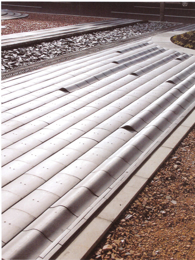
左：ノシ瓦とカメブスマの平敷きで2,620mm幅のボーダーをつくっている。カメブスマの凹凸とノシ瓦の柔らかい膨らみが大きなスケールの中で陰影をつくる。 右上・下：手前にサン瓦の小端立てを円形に配した部分。ノシとカメブスマのボーダーと円がぶつかる。(すべて2005年1月)
