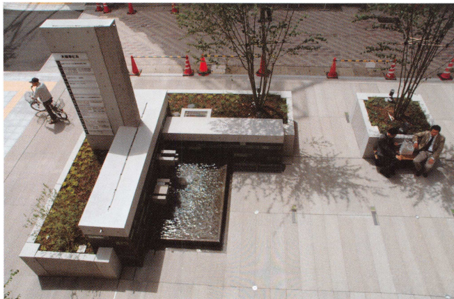
水景施設。舗装は1800×300のミカゲ石スクラッチ仕上げ。織部釉陶板などのモザイク模様と埋込型照明を散らしている。(2005年5月)
