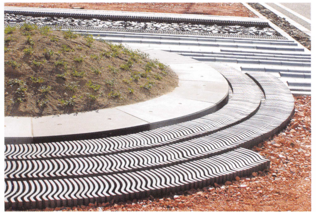
円周の小端立てサン瓦は動きが出るよう円弧の長さのバランスを見てデザイン。(2005年1月)
