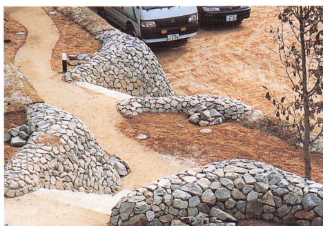
割栗石による石垣、角を丸めた階段
