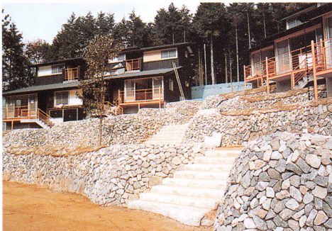
割栗石による石垣、角を丸めた階段
