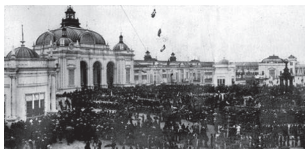
写10 第10回関西府県連合共進会(共進会事務報告)
