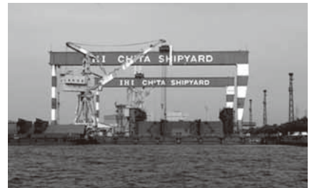
(H)北浜ふ頭・ゴライアスクレーン
