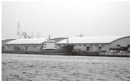
(C) 稲永ふ頭・海から見た倉庫群
