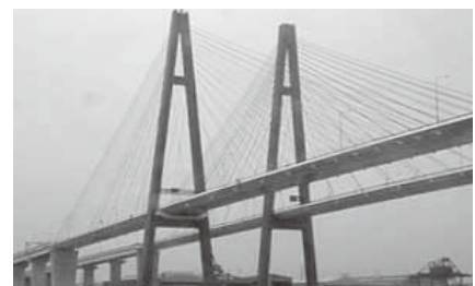
(C) 金城ふ頭・名港西大橋(名港トリトン)
