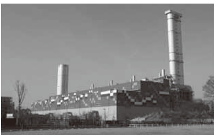
(H)潮見ふ頭・新名古屋火力発電所
