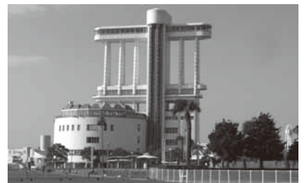
(F) ガーデンふ頭・ポートビル
