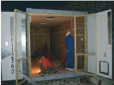
石彫道具の保管庫であったコンテナを発表空間として改装、その作業風景。
