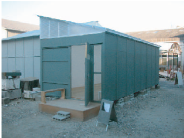
「future lounge」の外観、石材置き場にて。後方にあるのが石影場であり、「TPR」の背面、建設には時間が必要であり、建設と解体が重なることもある。
