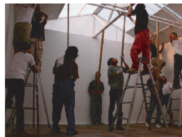
2003年、仮設空間「TPR」制作中風景。多くの空間がこのパネルによる壁面、屋根は部分ユニットで作られ、載せるという工法で建てられている。
