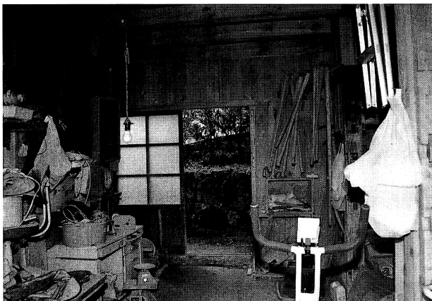
28 改修前 納屋1階 家畜部屋 入口
