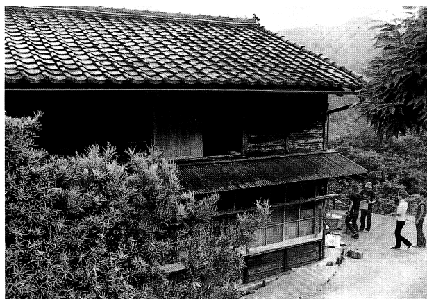
20 改修前 納屋 北側外観
