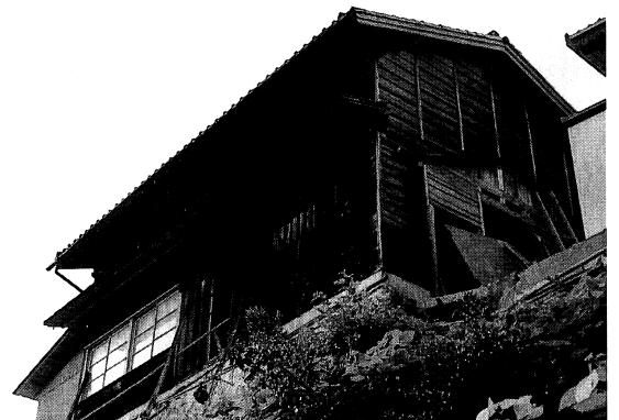
18 改修前 納屋 南側外観
