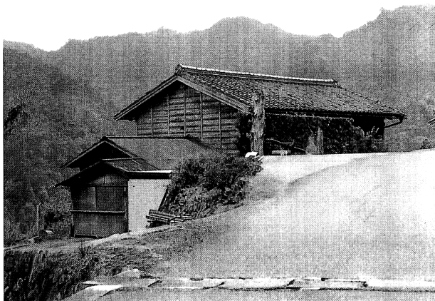
16 改修前 納屋 北側外観 アプローチ
