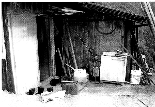
23 改修前 納屋 西側増築部
