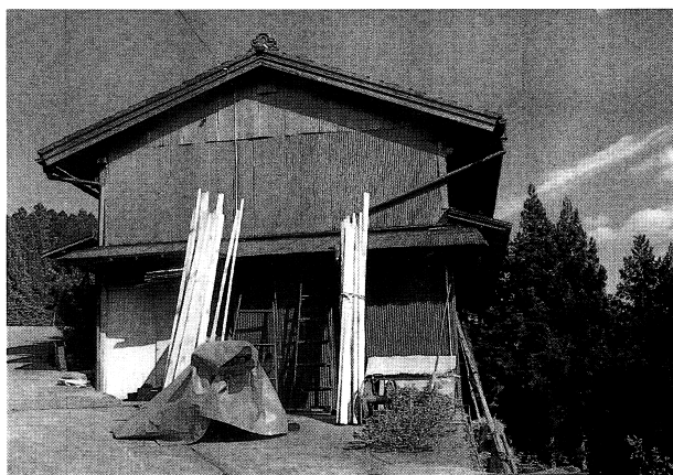
22 改修前 納屋 西側外観
