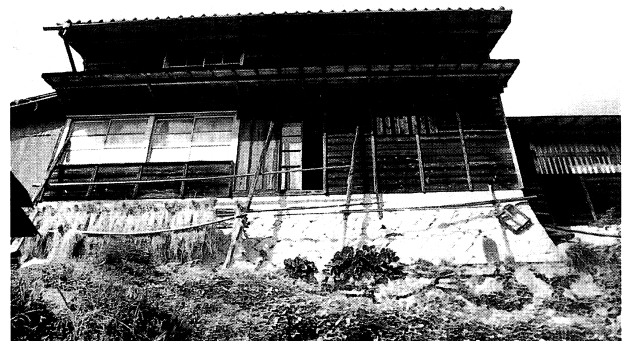
19 改修前 納屋 南側外観
