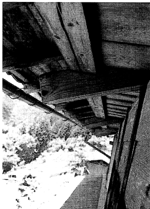
25 改修前 納屋南側 登梁 出桁
