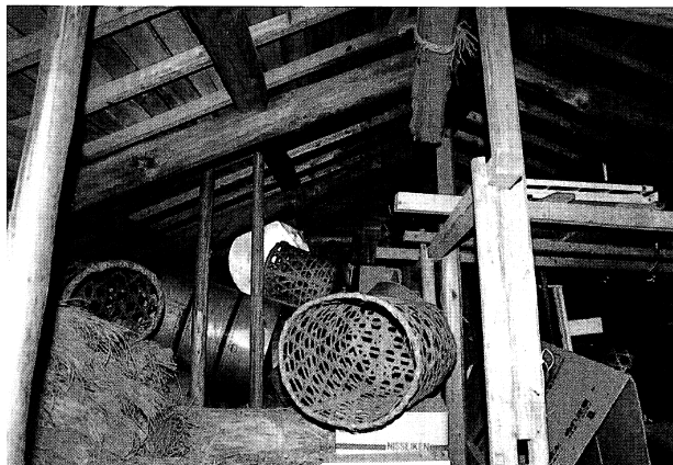
33 改修前 納屋 2階内観
