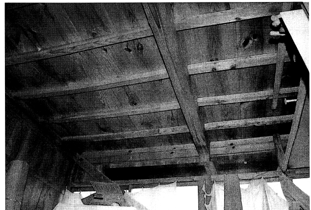
31 改修前 納屋1階 物置 天井
