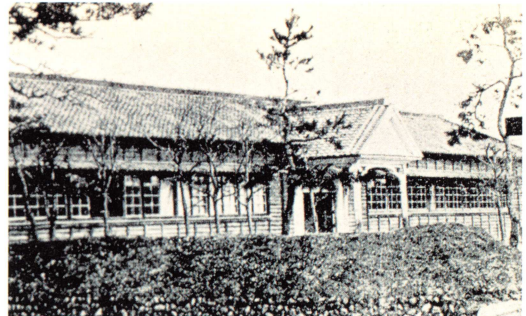
大湊造船徒弟学校校舎（明治38年頃）
