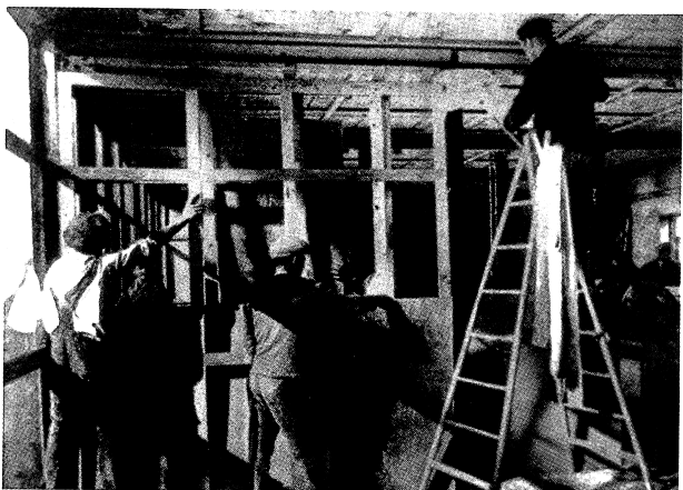
工事現場 乾式工法
