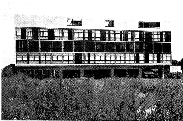
南側ガラスのファサード
