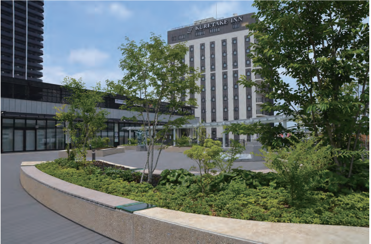
写真20 植栽地の周囲をベンチとして立ち上げることで土壌厚をなんとか確保。将来は少しでも木陰をつくってほしいと願う。奥にはガラスの庇。●
