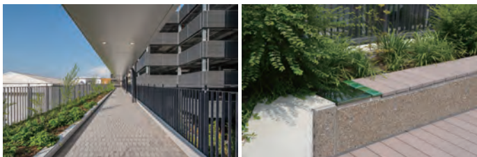
写真17 渡り廊下棟にも植栽スペースを設けた。●
