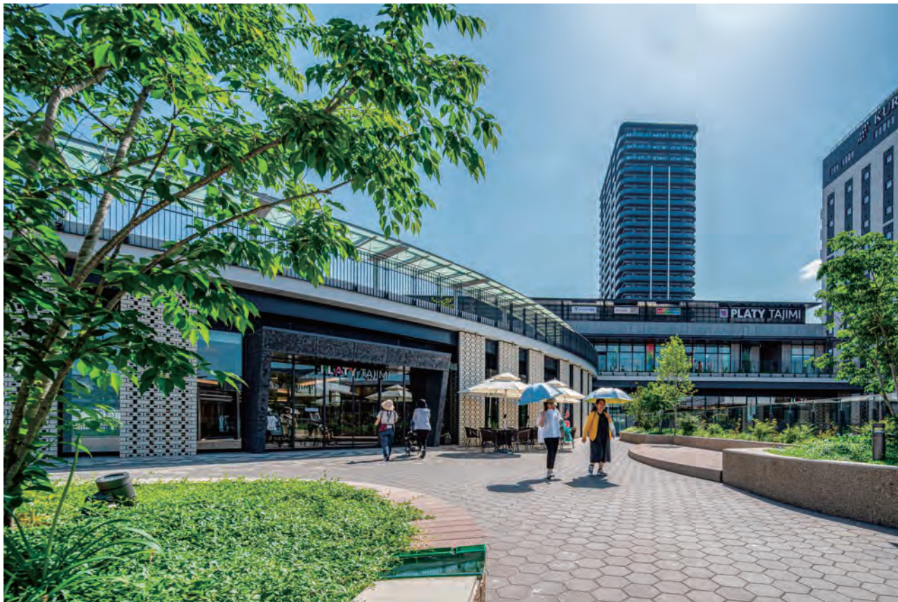
写真15 ペDESTリアンデッキから屋上庭園に入る。植栽樹の立ち上がりがベンチとなっている。右奥にはイベント用のデッキスペース。●
