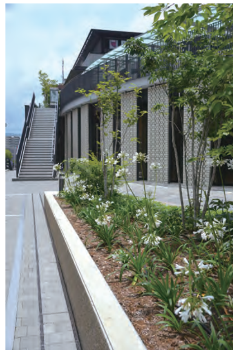
写真19 白いアガパンサスが咲く。奥には3階屋上庭園への階段。
