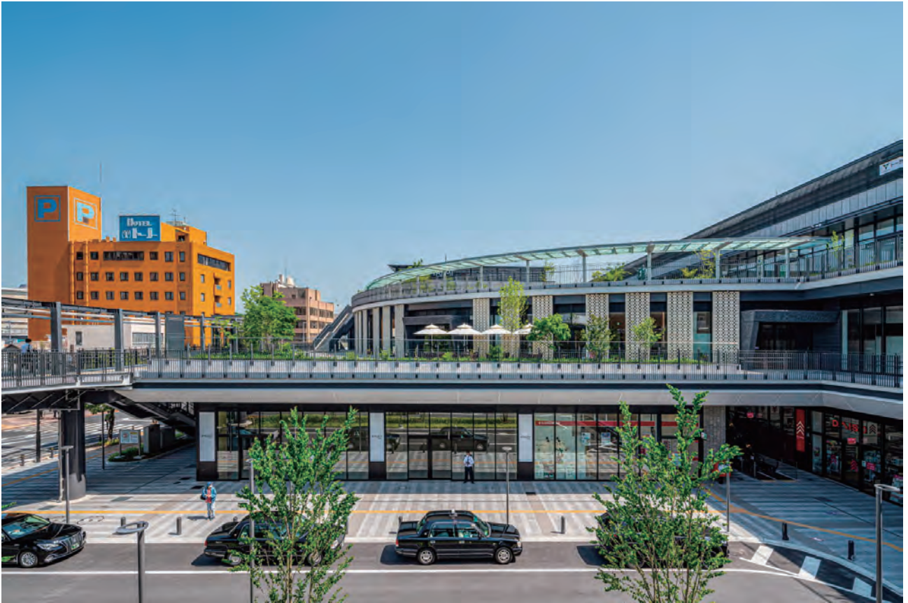
写真9 商業業務棟を交通広場越しに見たところ。事業区画が異なっても舗装のストライプがつながる。太いストライプ部分に再生セラミック材を使用。●
