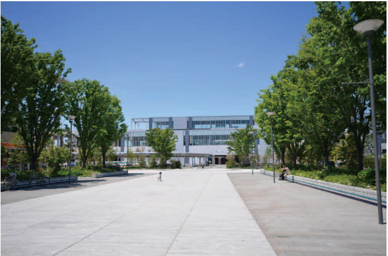
写真5 50m歩道の中心は山車の鉄の車輪が通っても支障の無いよう石舗装とした。インド産の波模様が美しい緑がかった花崗岩。両脇はコンクリート平板。透水性と非透水性を交互に並べ質感の違いでストライプ文様を出した。
