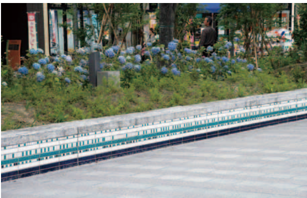
写真6 植栽の土留めを兼ねたロングベンチ。座面は舗装と同じインド石材。採石した際の石肌をそのまま使用している。立ち上がり部には海をイメージした釉薬 タイル貼り。
